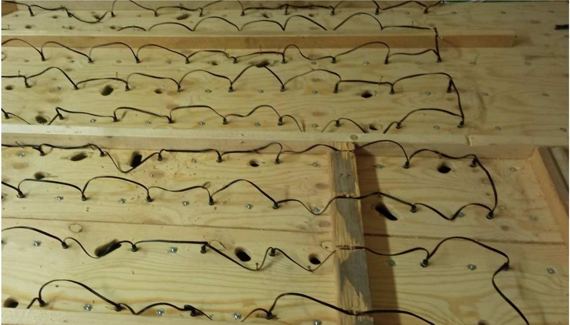
22. Die Kabelstränge zwischen den LEDs ggfs. befestigen, wenn bei den Fingerlöchern das Kabel stört. Wenn nichts Besseres zur Hand (wie z.B. Reichelt „KAB HAN 05-07“), dann kann man – wie hier gezeigt – auch improvisieren:
