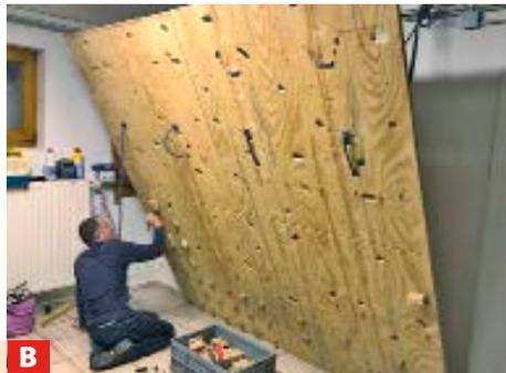
**B** Nicht nur die Wand, auch die Griffe sind selbstgebaut. Für besseren Grip werden sie mit Schleifpapier beklebt.
